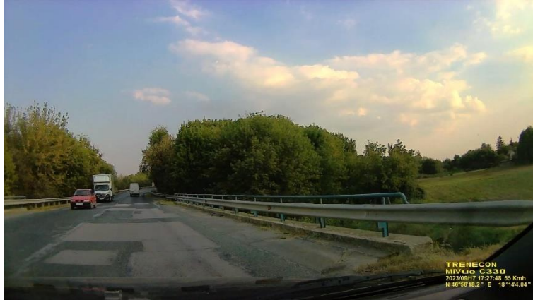
50. ábra A 64 sz. főút külterületi jellegű szakasza
